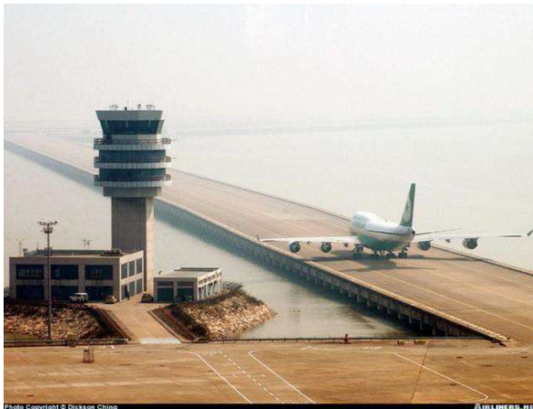
Рис. 2. Взлетно-посадочная полоса на свайном основании в море (иллюстрация из интернета, ©Diction China)
